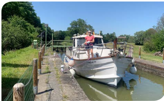
Resclosa de canal
