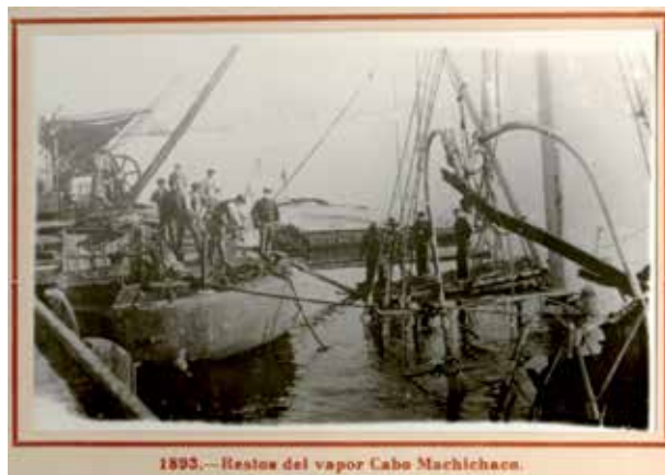
1893.—Restos del vapor Cabo Machichaco.
