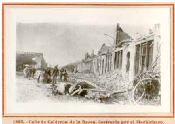
1893.—Calle de Calderón de la Barca, destruida por el Machichaco.
